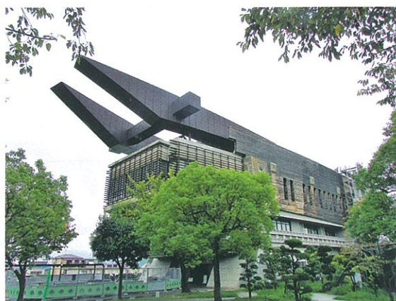
アイセルシュラホール (台風21号の被害を受け、右奥は修理中)
