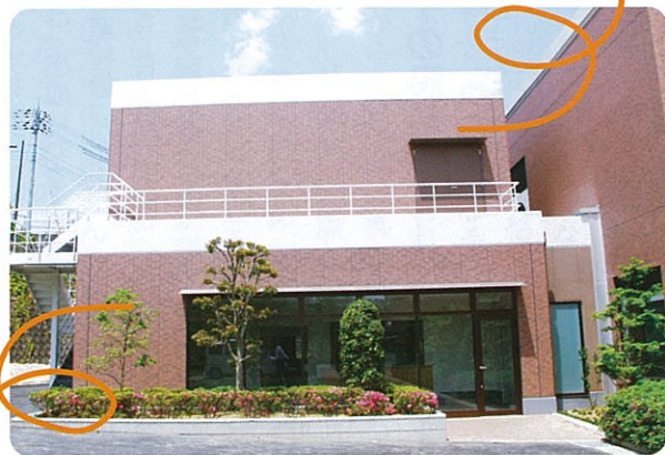
既存の建物との接続上、階下の歯科が「2階」、階上のiVRセンターが「3階」となります。
